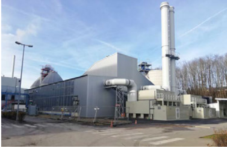
项目: 德国慕尼黑Zolling 型号: 2xBTU 1/6200-36-4/4 物料: 市政污泥 水分蒸发量: 2x8,200 公斤/小时
